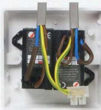
Электропроводка (в Европе: коричневый = под напряжением, синий = нулевой, зеленый + желтый = заземленный)
