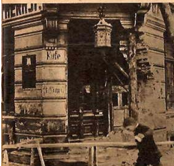
Durch Granatschuh beschädigtes Haus in München
