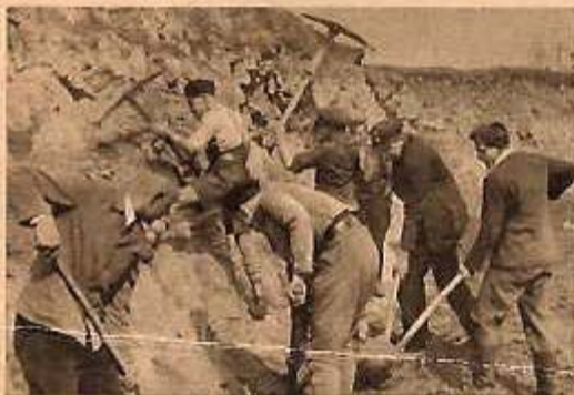
Zur Steinbruch wird das Rohmaterial zum Straßenbau von unseren jungen Arbeitsdienstpflichtigen gewonnen.
