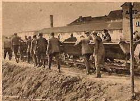
Koburger arbeitende Jugend auf der Baustelle. Es gilt, eine neue Ringstraße um die Stadt zu legen.
